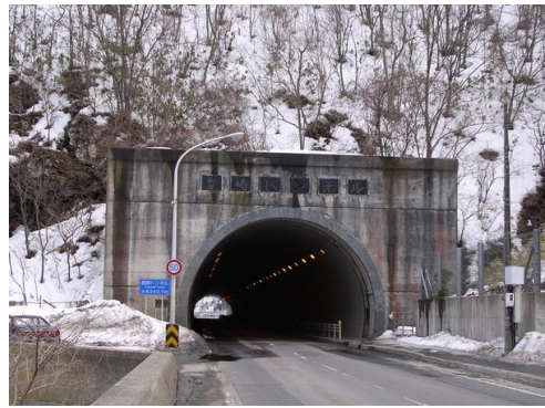
豊崎トンネルの上にモサシ峠旧道があった
